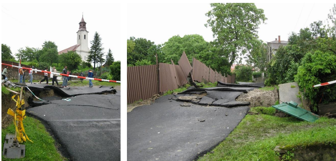
Príklad poškodenia objektov v obci Nižná Myšľa v roku 2010 spôsobených aktiváciou zosuvov vplyvom klimatických faktorov
